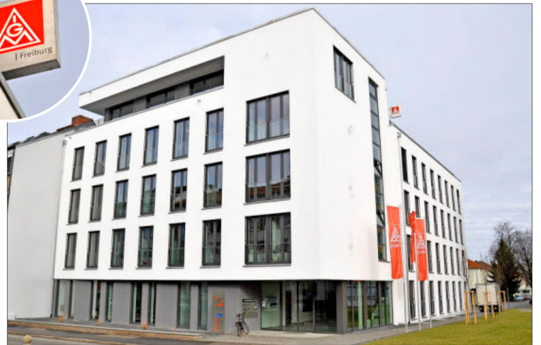
Das Gewerkschaftshaus in der Friedrichstraße ist modern und energiesparend
