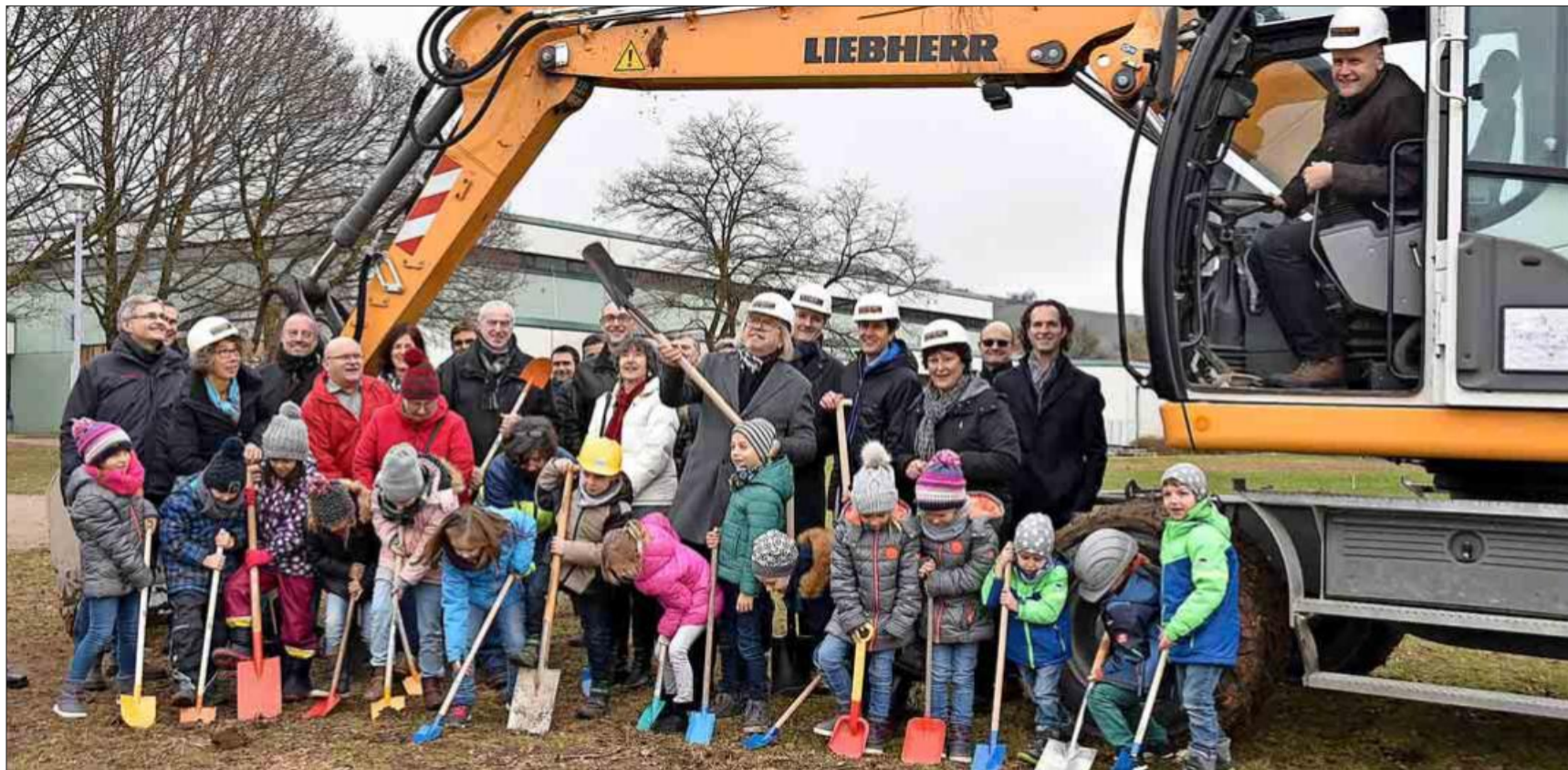
Schwer gearbeitet wurde beim Spatenstich vor allem von den Erstklässlern (vorne). Mit dabei unter anderem auch Architekt Richard Stoll (Mitte, mit großer Schaufel) und Bürgermeister Thomas Breig (im Führerhaus des Baggers).
