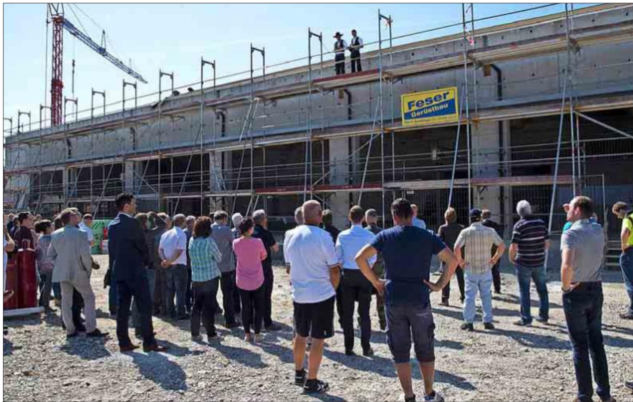
Bei strahlendem Sonnenschein konnte eine größere Schar geladener Gäste Richtfest feiern. FOTO: VOLKER MÜNCH
