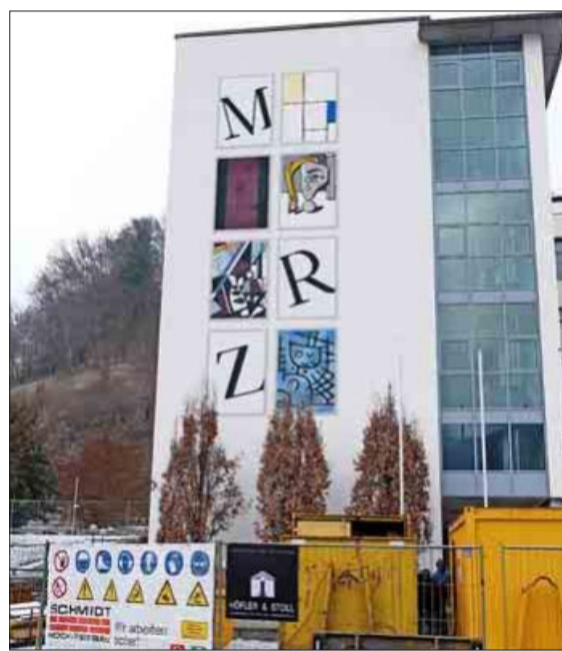
Umfassende Sanierungsarbeiten werden in den nächsten drei Jahren an der MORZ erfolgen.
